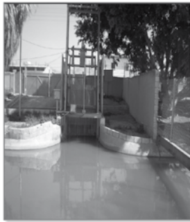
الشكل (٣-٢): إحدى منشآت تحويل المياه.
