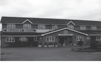
الشكل (١-٣): خانات قلنتة أصبحت فنادق.
